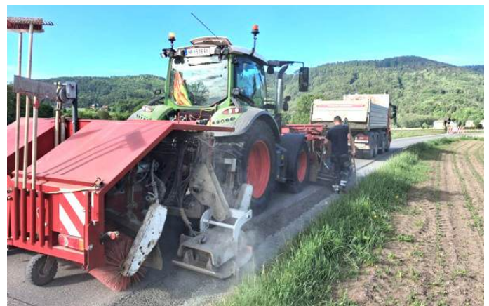
Bankettsanierung in Kerschbaum
