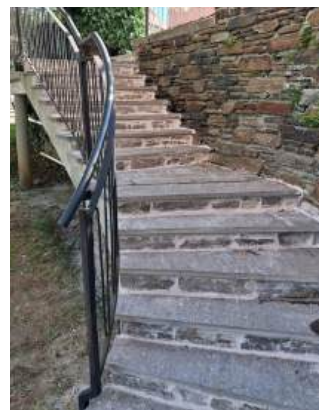
Erneuerung der Stiege am Kirchplatz
