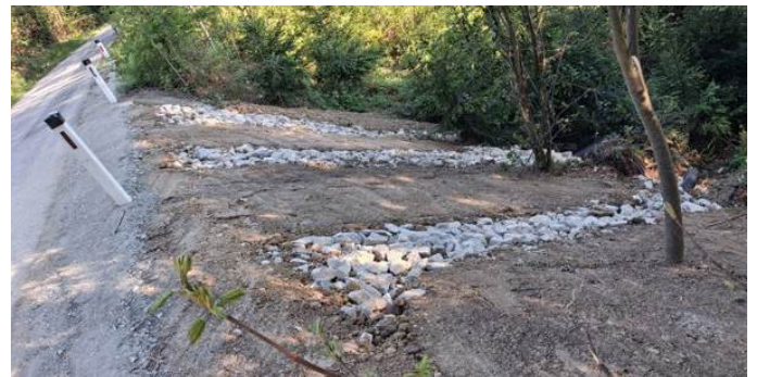
Sanierung Hangrutschung im Bereich Ganzer
